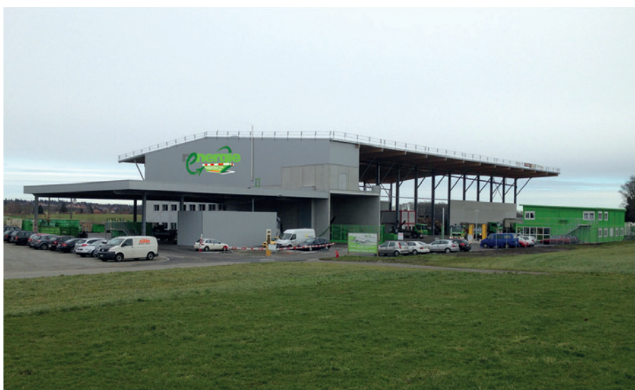
Der Neubau der Muldenzentrale OTG AG im Amriswiler Industriegebiet Buchenhölzli
